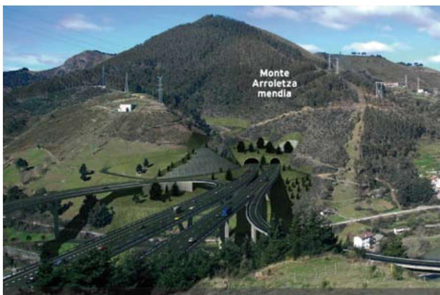
de entrada al tronco desde dicha Autovía. Ambos cruzan el río paralelamente conformando un solo tablero. En sentido Cantabria, a lo largo del trazado, se incorpora el ramal de entrada procedente del área de identificación y cobro de canon que forma parte del trayecto siguiente.
