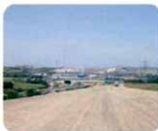
Puesta en obra exterior
