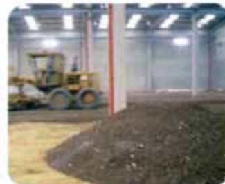
Puesta en obra interior
